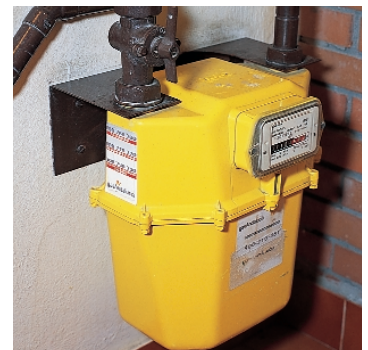
21. Contador individual y llave de corte.
