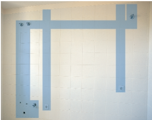
23. Bandas por donde discurren las instalaciones. Cocina.
